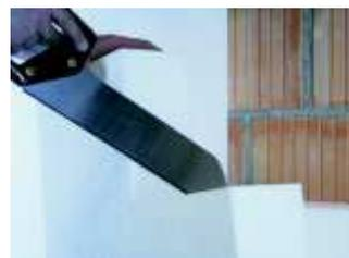
Appliquer le mortier adhésif sur la surface de collage du bloc de montage MTH QUADRO PU. L'élément doit être complètement collé sur toute la surface de la base.
